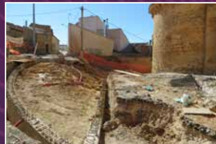
Inicio de las obras en el entorno de San Miguel
